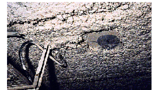
Flocage de plafond
